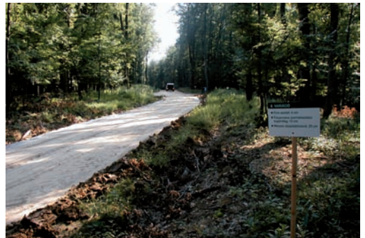
4. ábra: A földmű a mésszstabilizáció előtt és után. Figure 4: The earthwork before and after lime stabilization.
