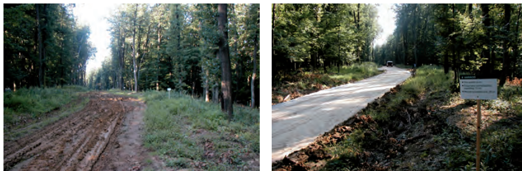
4. ábra: A földmű a mésszstabilizáció előtt és után. Figure 4: The earthwork before and after lime stabilization.
